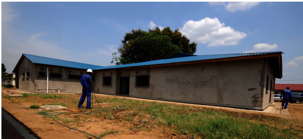
Le due sale operatorie in fase di realizzazione
